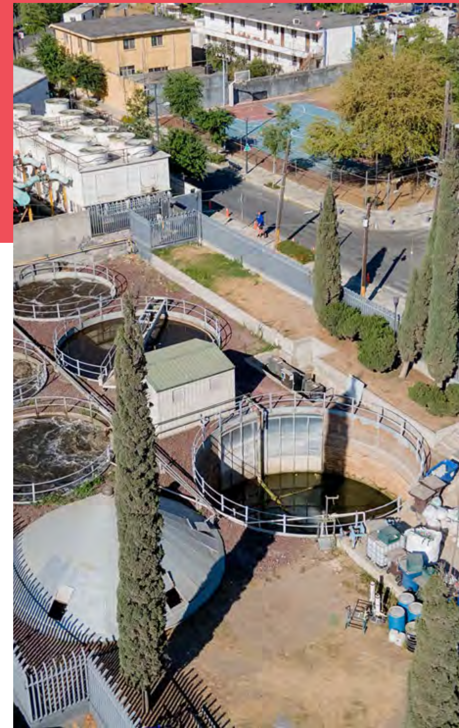
PTAR de Campus Monterrey
