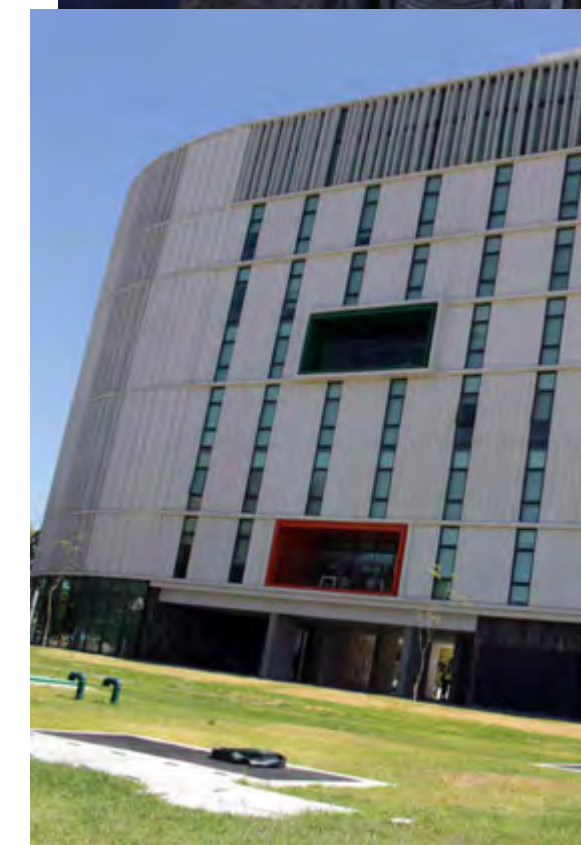
Sistema de captura de agua de lluvia y tanques enterrados para prevenir inundaciones, Campus Querétaro
